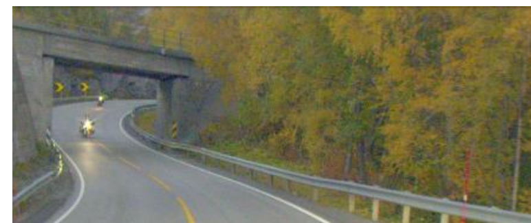
Fauske – Bodø. Foto: Statens vegvesen
