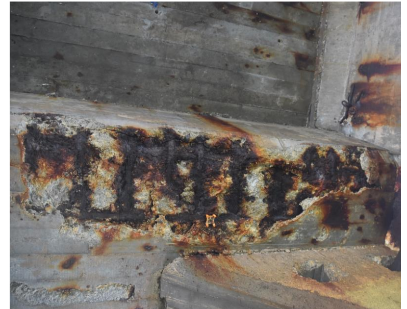
Avskalling m/kraftig korrodert armering
